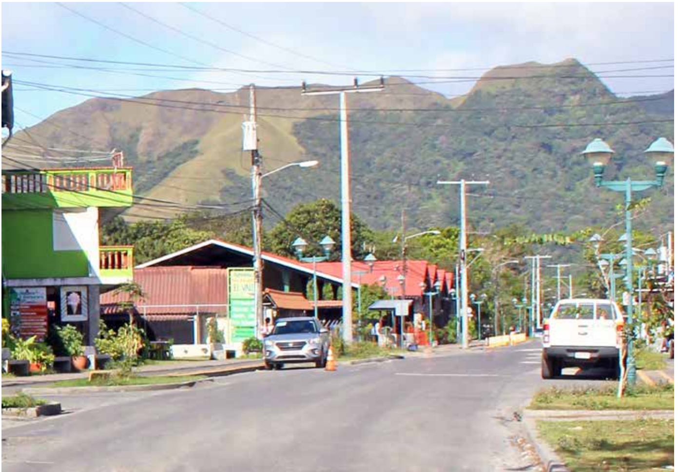
Calles, avenidas y construcción de siete puentes para la provincia de Coclé.
