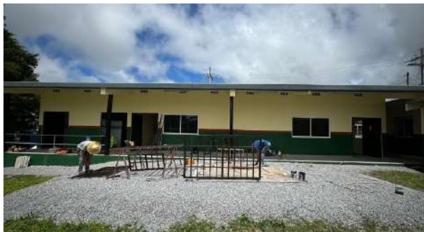
Construcción de aula, taller de Gastronomía / Hotelería, Módulo de baños y gazebo del CAIPI en Volcán.
