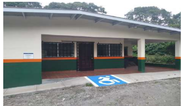
Acondicionamiento del Módulo de la Finca Agropecuaria del IPHE de Boquete.
